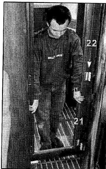
21 - Déboîter la porte 4 pour présenter le chambranle. 22 - Clipser le chambranle et revisser les caches. (Voir 2) 23 - Remettre la porte en place.
